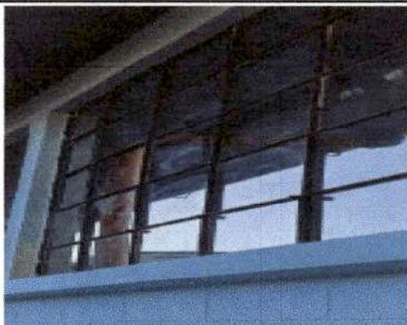
Foto1: Sustitucion de vidrios en modulo de Aulas
