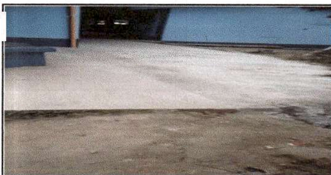
Foto 5: Reparación de plancha de concreto de patio
