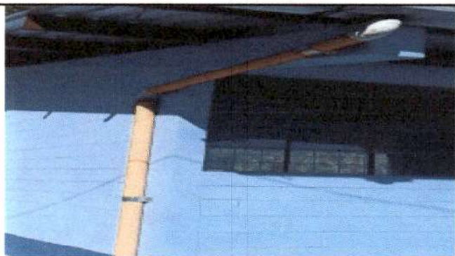
Foto 3: Canaes y bajadas de agua pluvial modulos de Aula.
