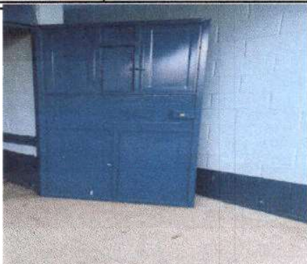
Foto7: Mantenimiento a estructuras de puertas de metal modulo de Aulas.
