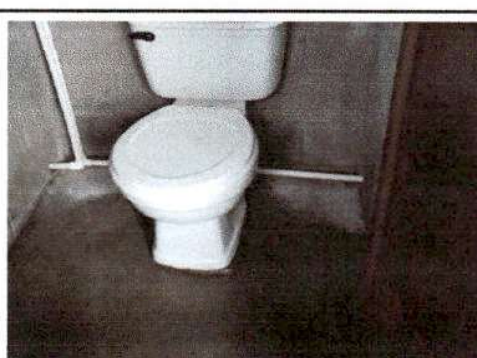
Foto 6: Sustitucion de Inodoro en modulo de Baños.
