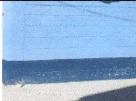
Foto 2 : Pintura en muros en exteriores en modulo de Aulas.
