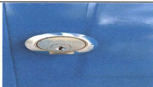
Foto 4: Sustitución chapas en modulo de Aulas.
