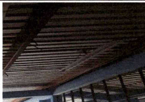
Foto 8 : Sustitución de lamparas marca Led modulo de Aulas.
